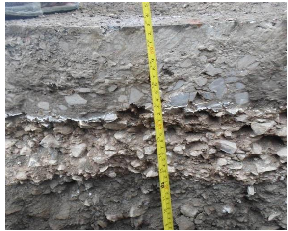
(d) Test pit at Makambako-Mbeya road section
