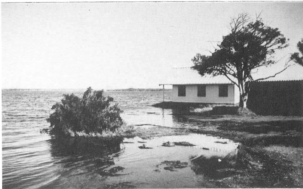
FIG. 26: Flooded house at Maanskynbaai (87-07-29).
